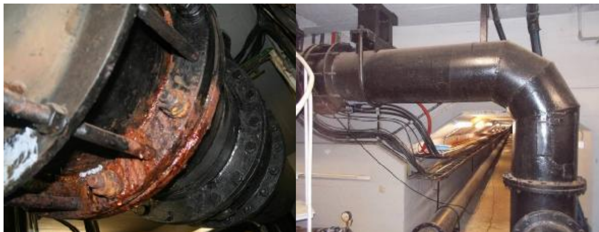
Poškozené potrubí DN500 v levobřežním pilíři
